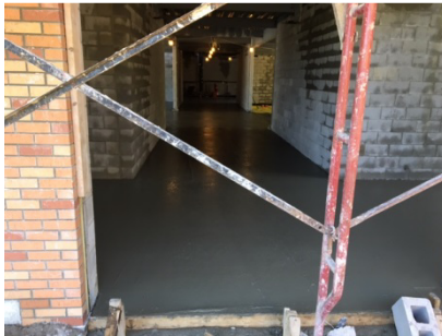
Sprague – Lower Level Floor Slab Pour
